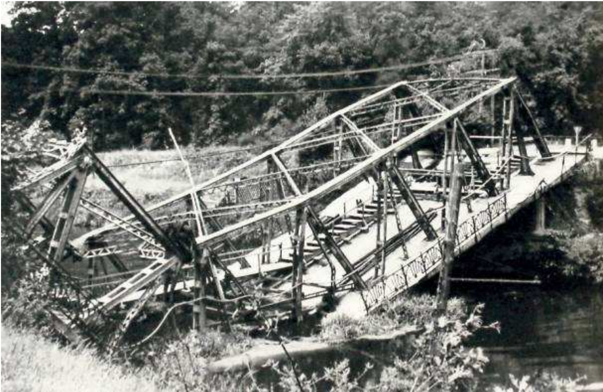
Unter den Brücken, die die Wehrmacht am Teltowkanal zerstörte, war auch die Badewitzbrücke (heute Friedensbrücke) in Kleinmachnow. Foto: Archiv Käbelmann
