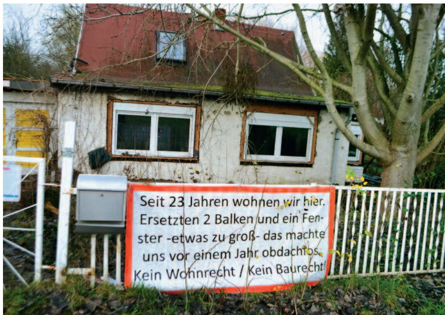
Dieses Haus wurde vor Jahren verlassen, wie 15 andere in der Siedlung
